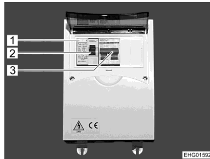
Afb. 134 230-V-zekeringenkast met beveiligingsautomaat en RCD (hoofdschakelaar)
