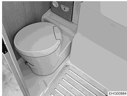
Kuva 168 WC-istuin, käännetty seinää päin
