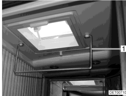
Kuva 162 Vaadetanko pyykin kuivaamista varten
