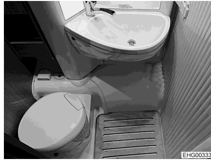
Kuva 164 WC-istuin, käännetty seinää päin
