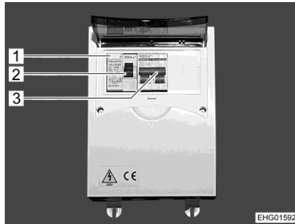
Kuva 134 230 V:n sulakerasia, johdinsuojakytkin ja vikavirtasuoja (pääkytkin)
